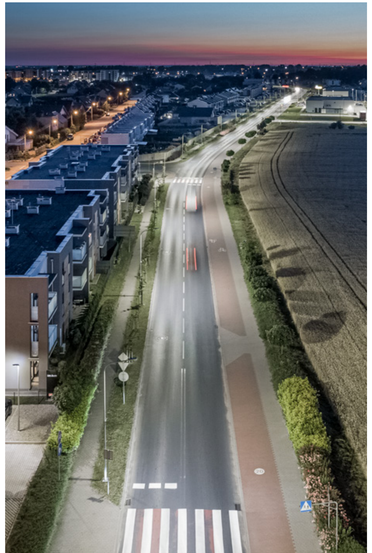
Oświetlenie drogowe w Środzie Wielkopolskiej
