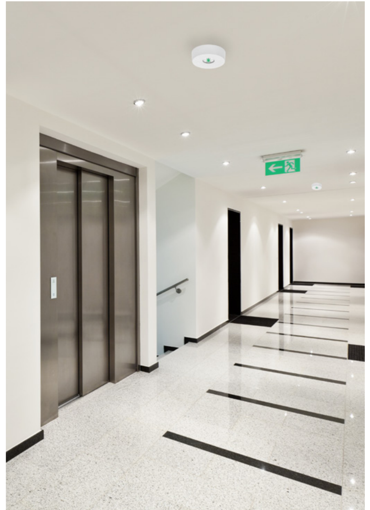
Zastosowanie lampy DOT CS LED w korytarzu w apartamentowcu.
