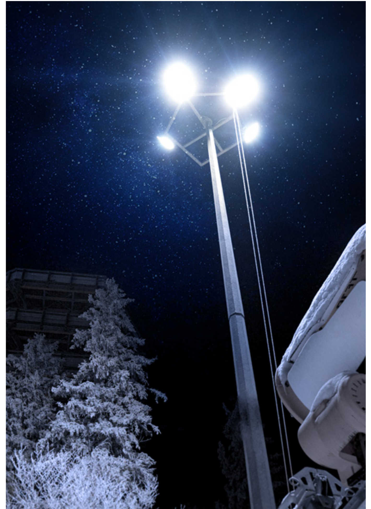
Oświetlenie stoku narciarskiego Stotwiny Arena
